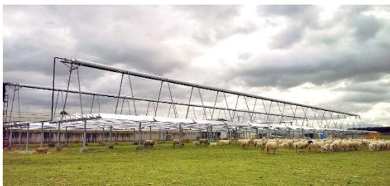
LUCE $FP$  è un collettore solare Fresnel a basso costo e alto rendimento da utilizzare in impianti solari utility-scale o per incrementare la potenza di impianti convenzionali. E' una soluzione *low cost* anche per produzioni elettriche contenute e decentrate, grazie alla sua modularità, all'utilizzo efficiente dello spazio e alla flessibilità nell'utilizzo di fluidi ad alta temperatura.
